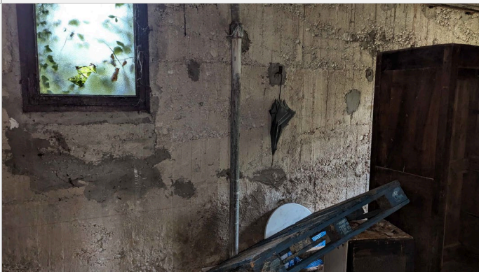
Grille d'évaluation n°3 : Conduits de fluides en amiante-ciment dans sous-sol 1
