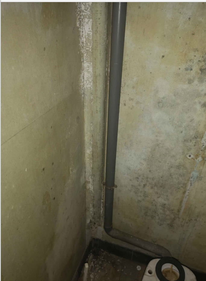
Grille d'évaluation n°5 : Conduits de fluides en amiante-ciment dans W.C.
